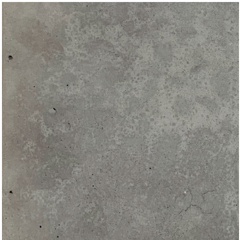
gevelbekleding horizontale banden architectonisch beton
