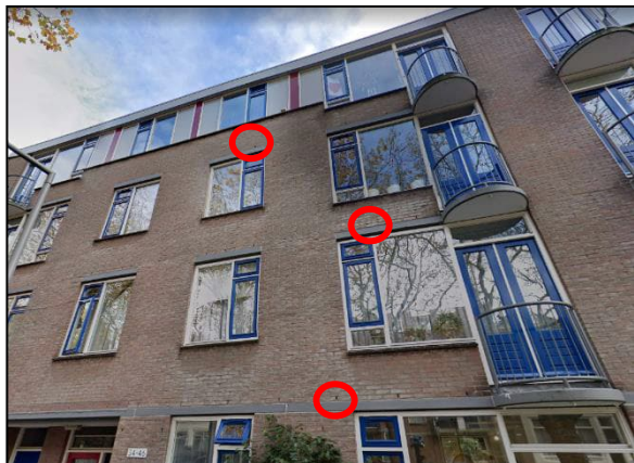
Figuur 5. Bebouwing aan de Teilingerstraat 34-46. Enkele open stootvoegen zijn ter illustratie aangegeven met een rode cirkel.
