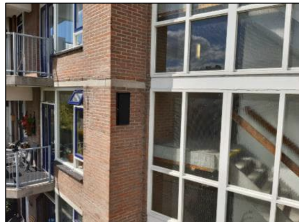
Afbeelding 3. Eén vleermuiskast geplaatst aan de bebouwing van de Heer Bokelweg 9-81 met oriëntatie op het noordoosten.
