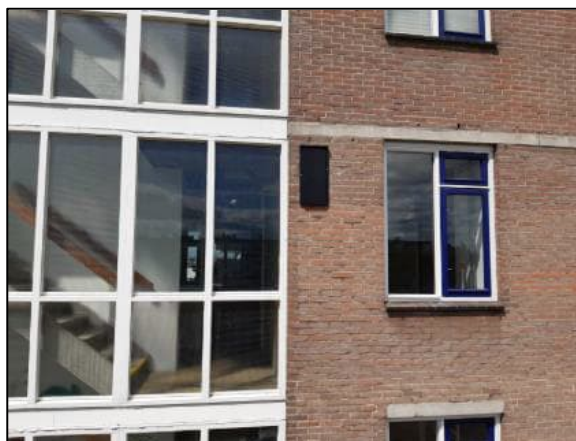
Afbeelding 5. Eén vleermuiskast geplaatst aan de bebouwing van de Heer Bokelweg 9-81 met oriëntatie op het zuidoosten.
