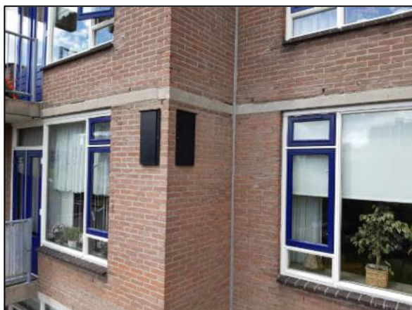
Afbeelding 4. Twee vleermuiskasten geplaatst aan de bebouwing van de Heer Bokelweg 9-81 met oriëntatie op het zuidoosten en noordoosten.
