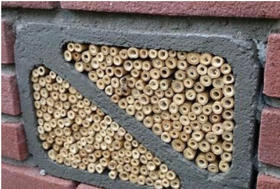
Figuur 5. Bijensteen gevuld met bamboe- of rietstengels.
