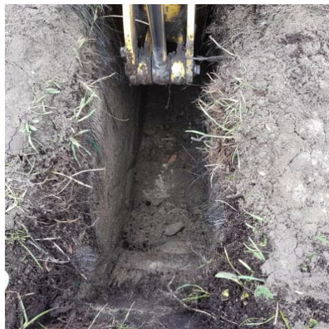
Foto 2: gegraven sleuf tpv boring 435.
