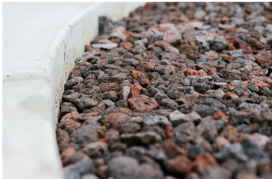
Waterdoorlatende laag t.b.v. afwatering
