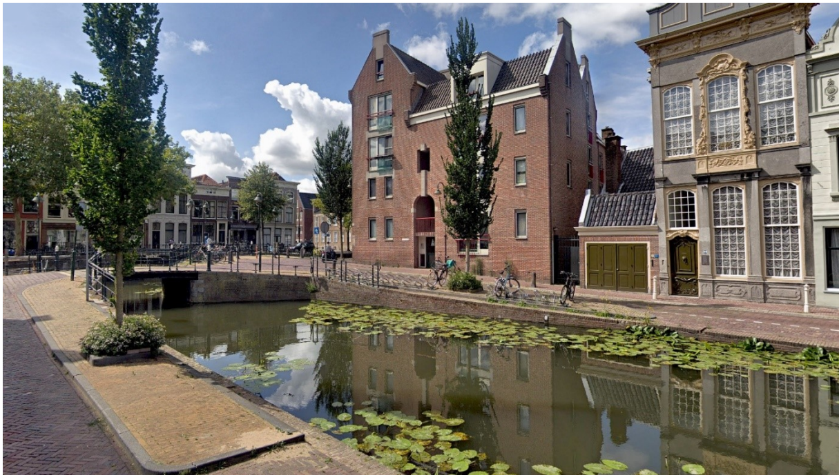
Foto locatie peilscheiding en gemaal met op de achtergrond de Turfbrug
