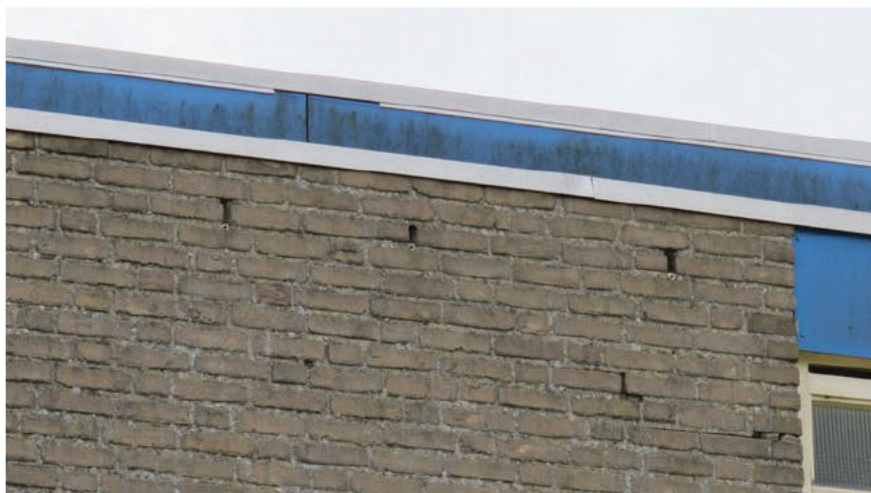
Afbeelding 25: Open stootvoegen in bakstenen geveldeel gebouw A.
