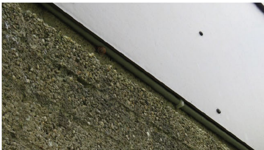
Afbeelding 23: Aan de voorzijde van gebouw A bevindt zich een kabel strak onder het trapeza gevelpaneel, hierdoor is er geen toegang voor vleermuizen onder het paneel.
