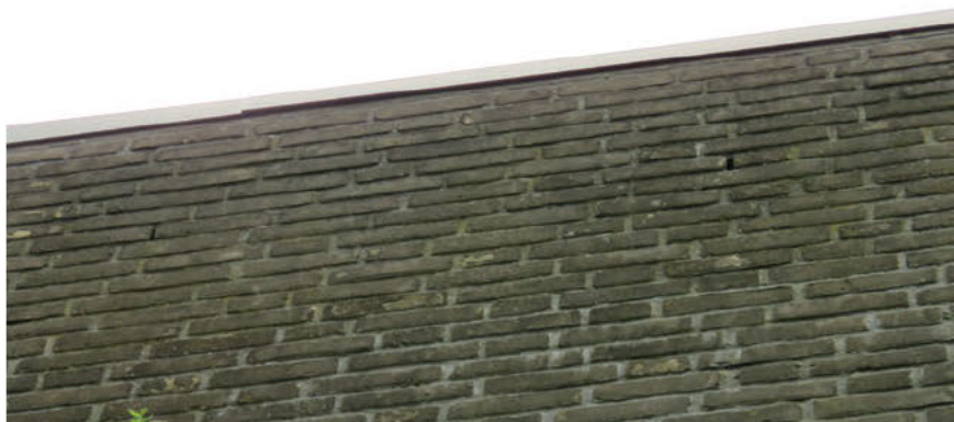
Afbeelding 31: Open stootvoegen in gevel bij entree
