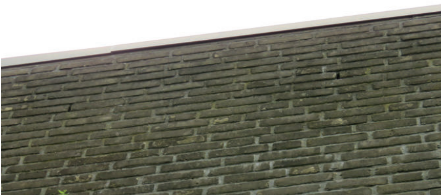
Afbeelding 12: Open stootvoegen in gevel bij entree van "schoolgebouw C", deze zullen ontoegankelijk gemaakt worden middels het plaatsen van exclusion flaps.
