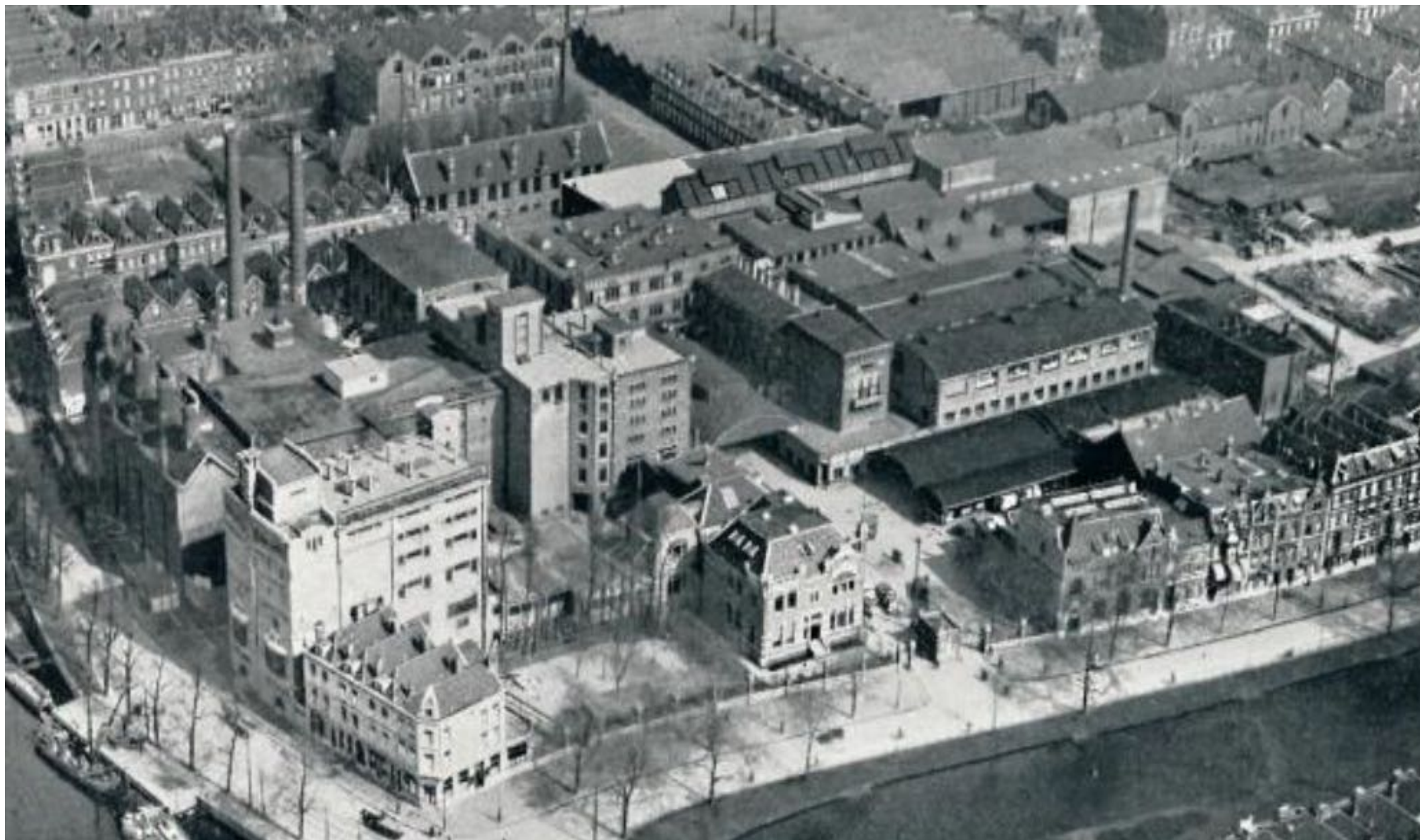
0348 • Verbouwing en uitbreiding van een kantoorgebouw (rijksmonument) aan de Crooswijksesingel 50 te Rotterdam 22 november 2022 • OV-00 • toelichting
