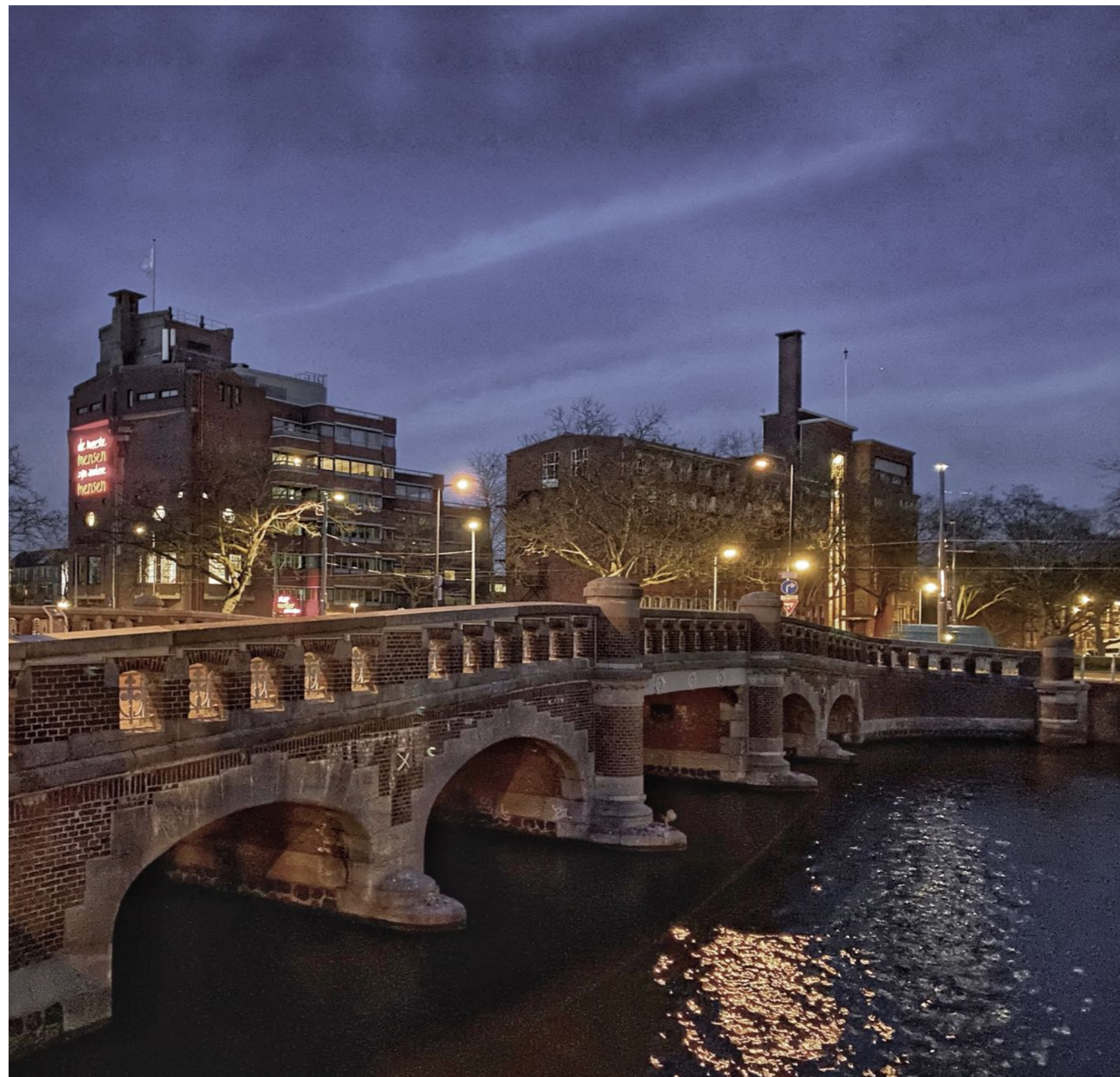
0348 • Verbouwing en uitbreiding van een kantoorgebouw (rijksmonument) aan de Crooswijksesingel 50 te Rotterdam 22 november 2022 • OV-00 • foto's bestaande toestand
