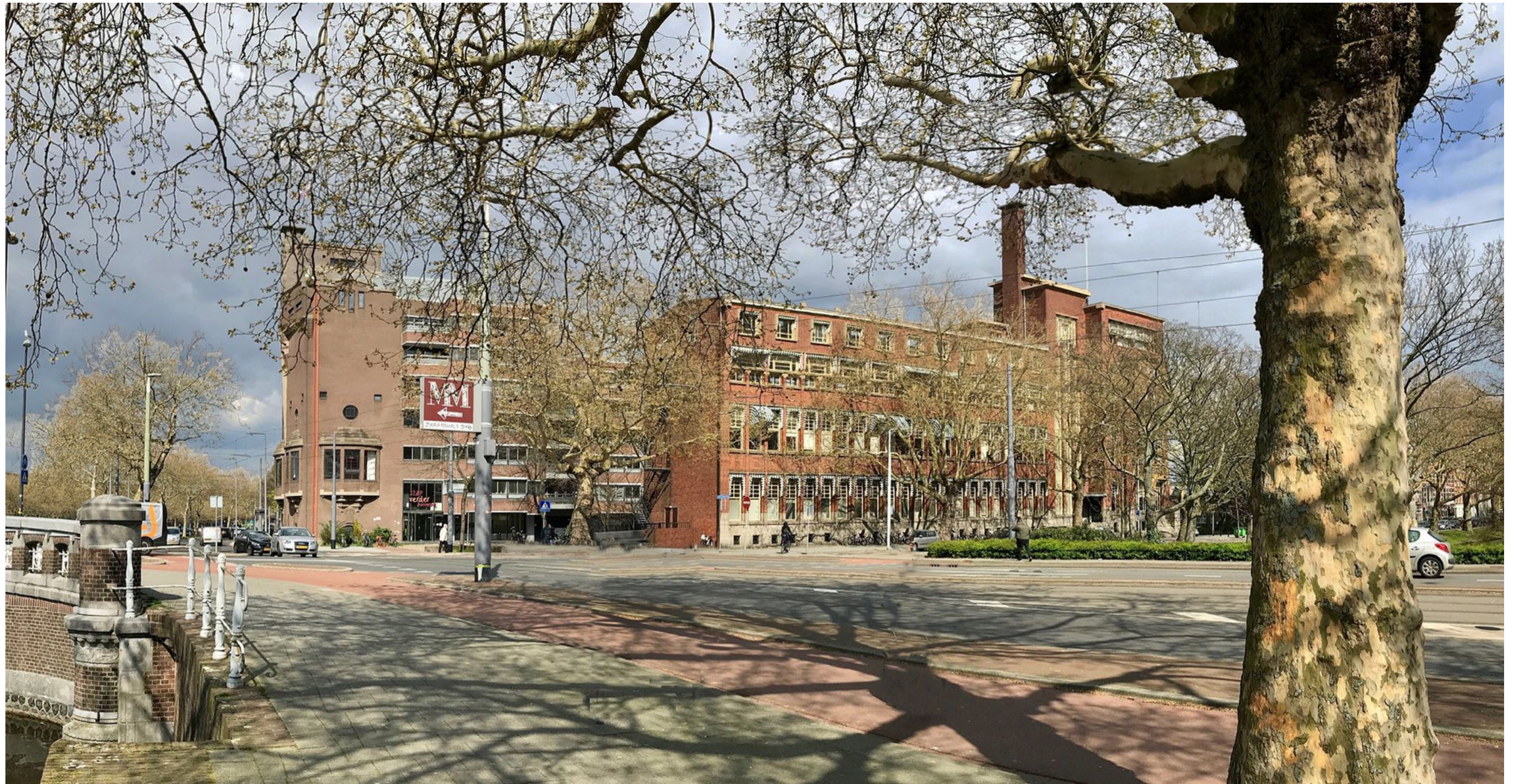
0348 • Verbouwing en uitbreiding van een kantoorgebouw (rijksmonument) aan de Crooswijksesingel 50 te Rotterdam 22 november 2022 • OV-00 • foto's bestaande toestand
