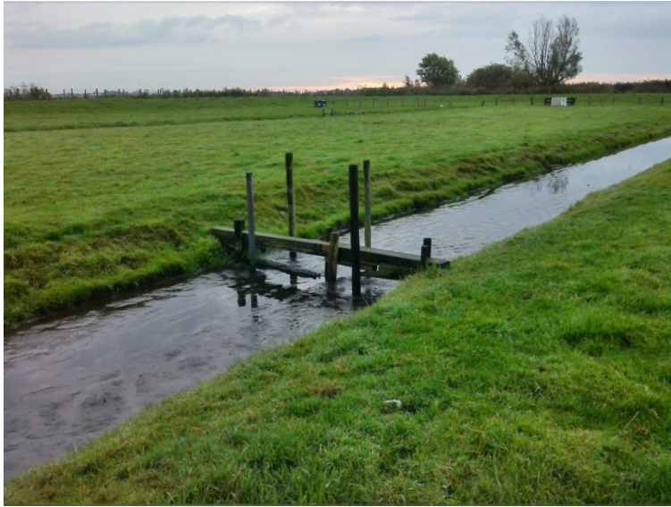
Figuur 3-4 Baggerachterstand watergang 074-058-00060-01, OR-3.30.02
