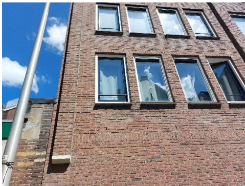
Figuur 9 Gebouw ten zuiden van de onderzoekslocatie met open stootvoegen.
