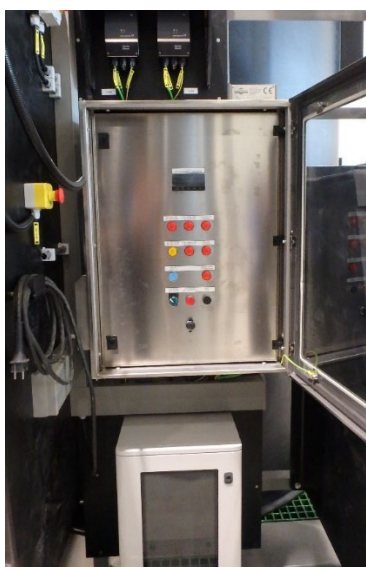
Foto 4; Besturingskast met daaronder een PBM kast
