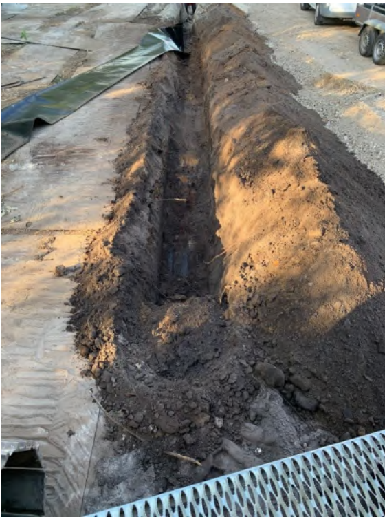
Foto 9 Toepassen schedingsdoek langs wand W03
