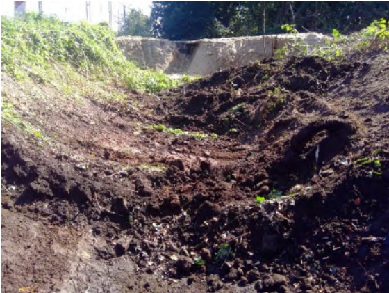
Foto 1 start ontgraving slootbodem
