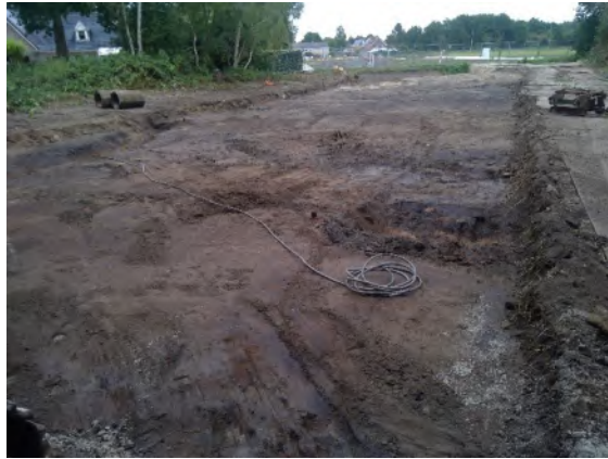
Foto 8 Eindsituatie sanering wegtracé
