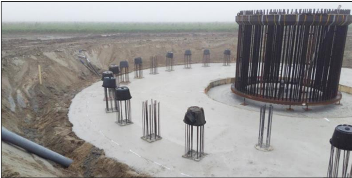
Figuur 3.3 Ankerkooi en wapeningsstaal heipalen (voorbeeld)
