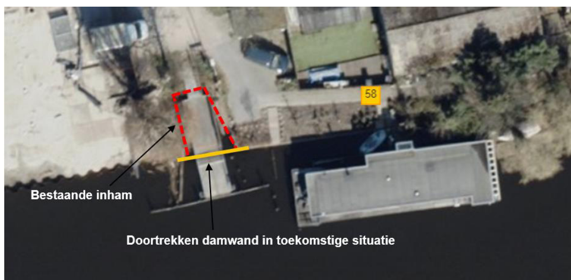
figuur 5-1: Bovenaanzicht huidige situatie ter plaatse van het pontje.
