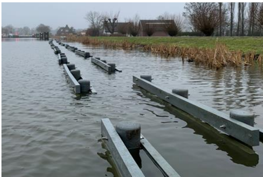
Figuur 27: Aangelegde golfbrekers bij dijverbetering Jaagpad
