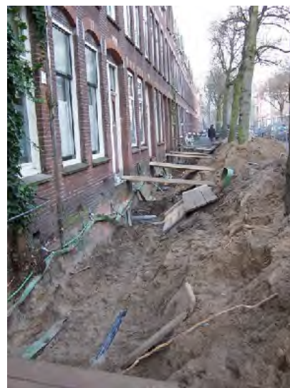
Figuur 6: Werk aan kabels en leidingen.
