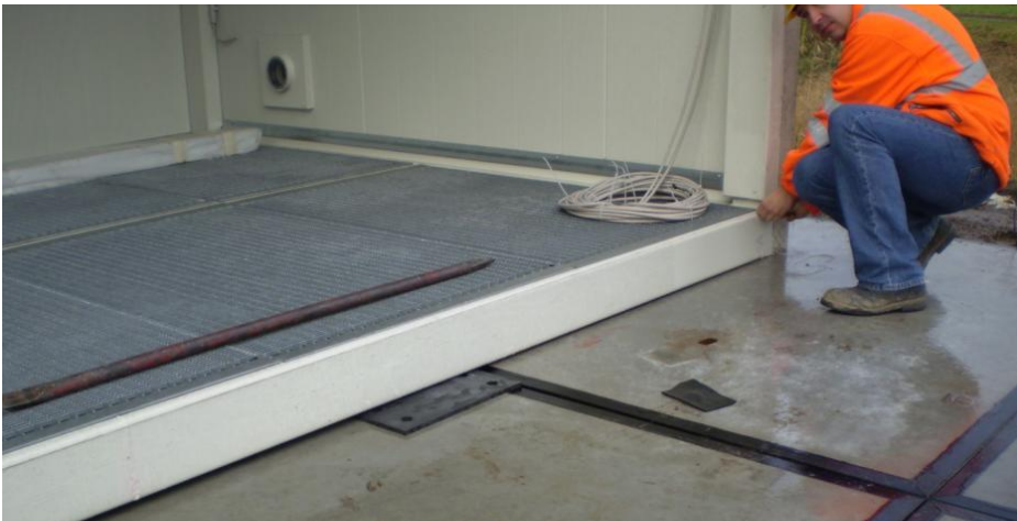
Montage op locatie.
