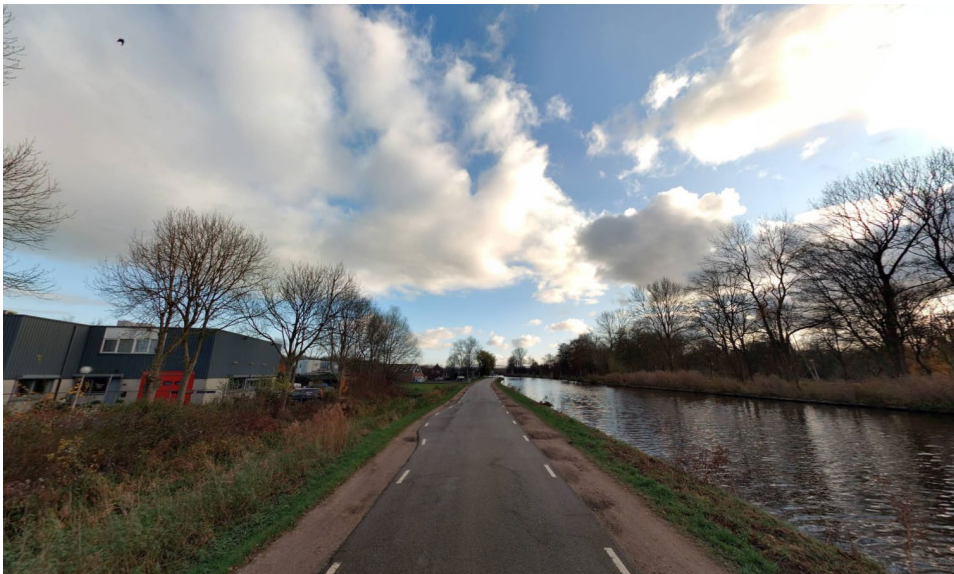
Noordkant Stammerdijk, rand bedrijventerrein met opgaande begroeiing. Teensloot tussen bedrijventerrein en een steil binnentalud. Kruin van de dijk met is geasfalteerd, de berm van de weg heeft een halfverharding. Het flauw aflopende buitentalud is van gras en de oever heeft een houten beschoeiing. Er is geen rietbeplanting aanwezig.
