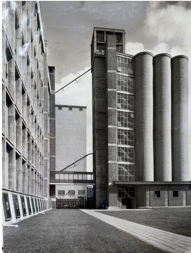
Originele brug ontworpen door Jo Vegter 1954
