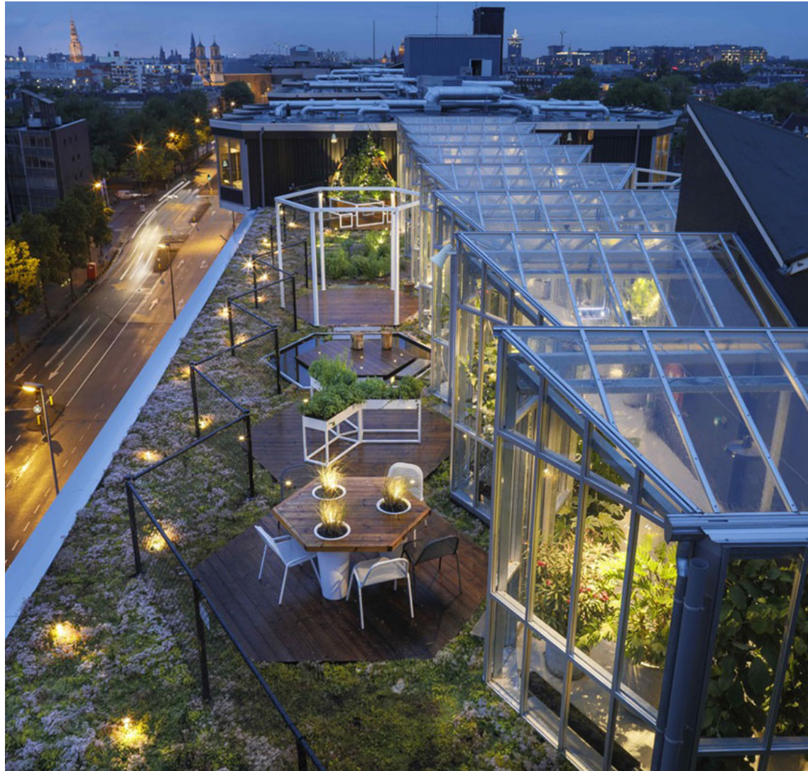
Op het dak van het Molengebouw kan een bijzonder plek gecreëerd worden.
