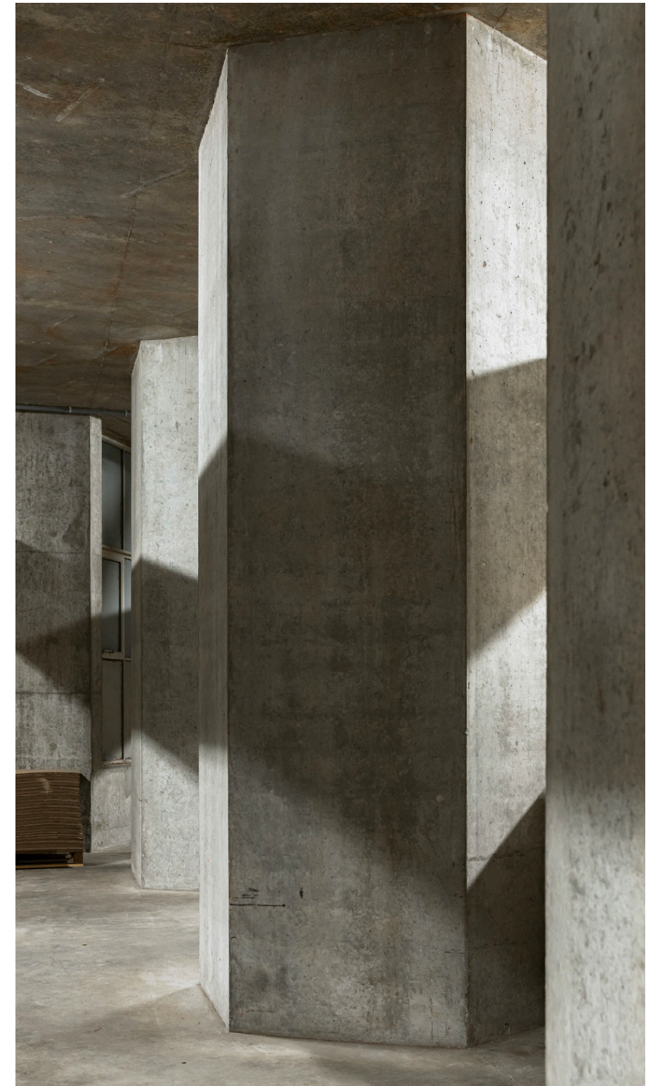
De bestaande betonnen zeskantige kolommen
