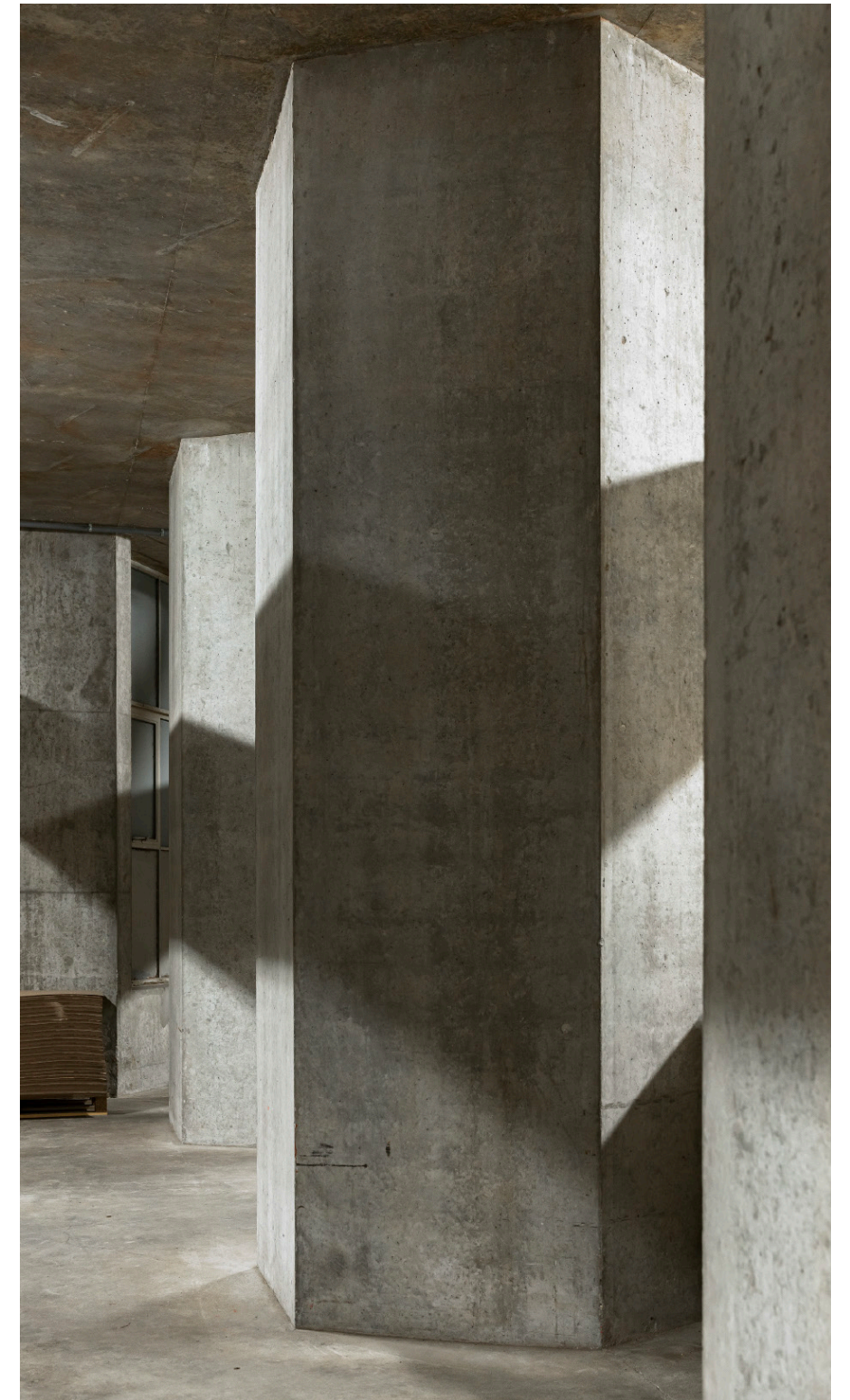
De bestaande betonnen zeskantige kolommen
