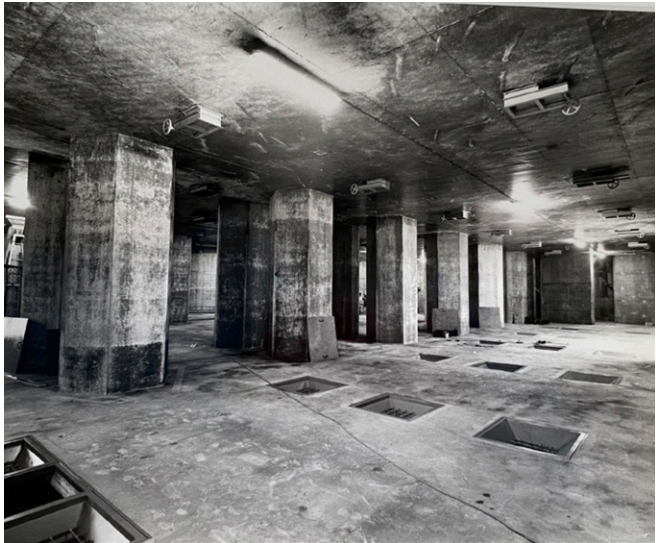
Begane grond van de silo-uitbreiding, met zware constructie en roosters in de vloer naar de kelder (Archief Vegter, HNI).
