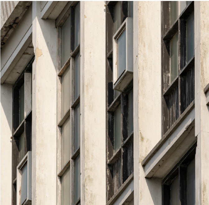
Licht geschilderde betonnen constructie met zwart geschilderde betonnen panelen en kozijnen
