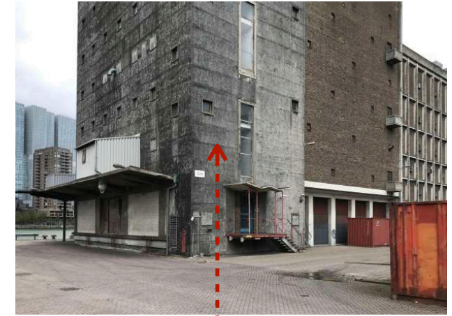
deel van het beton is afgewerkt met een laag bitumen met zand en schelpjes
