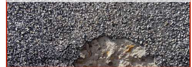
deel van het beton is afgewerkt met een laag bitumen met zand en schelpjes
