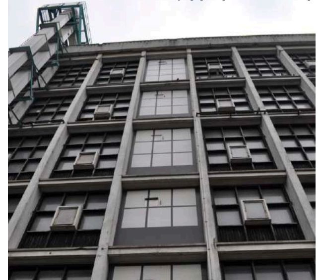
herstelde travee aan de noordzijde met geschilderde kozijnindeling, waardoor de installaties naar binnen zijn gegaan [bron: Crimson 2020]
