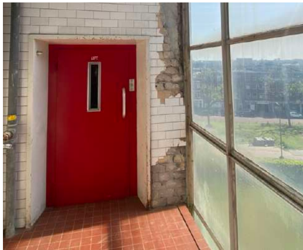
Liftdeur en liftbediening C.L1
