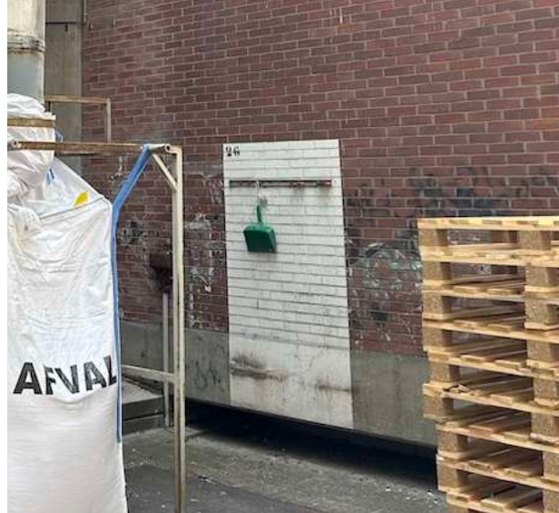
Productielijn relict op de oostgevel van het trafohuis
