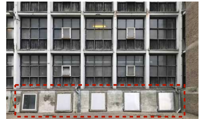
plintramen zijn vervangen: onder de huidige situatie, rechts de oorspronkelijke situatie
