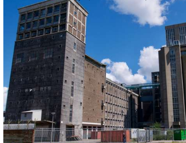
afwerking van 'boekensteunen' is anders dan het tussengelegen vlak: bitumen met zand en schelpjes (zicht vanuit zuidwest)
