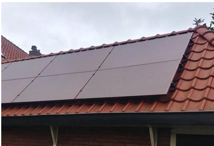
Een voorbeeld van zonnepanelen aangebracht op een bijgebouw, in een rechthoekig vlak, niet of beperkt zichtbaar vanaf openbaar toegankelijk gebied en met dezelfde kleurstelling als het onderliggende dakvlak.
