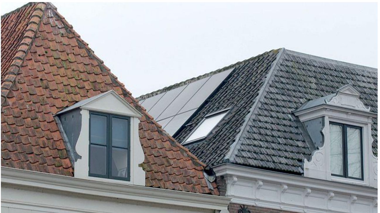
Een voorbeeld van zonnepanelen die beperkt zichtbaar zijn en in dezelfde kleurstelling hebben als het dakvlak. Bron afbeelding: EenVandaag
