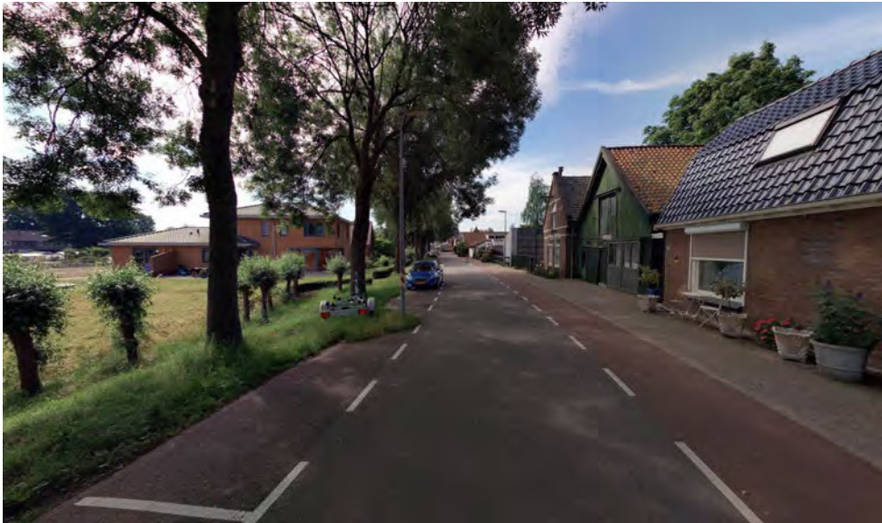
Naast de teensloot staan aan de onderkant van het binnentalud een rij knotwilgen. Aan de bovenkant van het talud staan een aantal essen. Op de kruin van de dijk liggen aan de binnenzijde de parkeerplaatsen en lichtmasten, aan de buitenzijde een fietssuggestiestrook. De huizen staan op de bovenkant van het buitentalud, de Gaasp is hierdoor niet zichtbaar.
