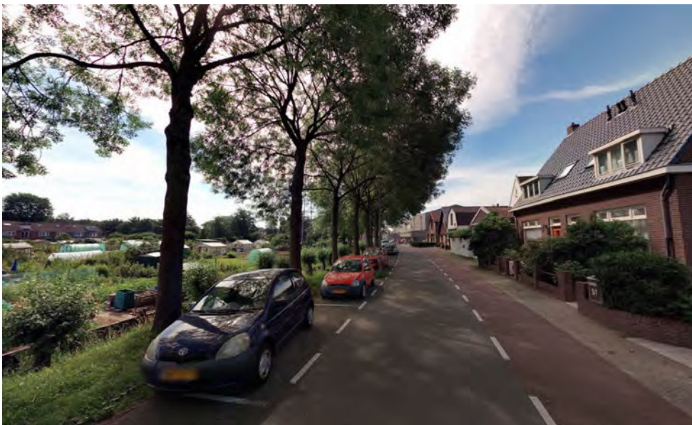
De teensloot heeft een houten beschoeiing, en vormt de scheiding tussen de volkstuinen en de dijk. In het steile binnentalud staat een rij essen. Op de kruin van de dijk liggen aan de binnenzijde de langspaarkeerplaatsen, aan de buitenzijde een fietssuggestiestrook. De huizen en voor/zijtuinen staan op de bovenkant van het talud. Door de aaneenschakeling van woningen zijn er geen doorzichten naar de Gaasp.
