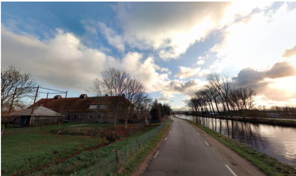
Teensloot aan de voet van het binnentalud. Het steil oplopende binnentalud wordt gebruikt als schapenwei, en heeft aan de bovenkant van het talud een hekwerk. De kruin is uitgevoerd in zwart asfalt en de berm is aan de binnen en buitenzijde deels half verhard. Het smalle buitentalud loopt flauw af en er is vrij zicht op de Weespertrekvaart.
