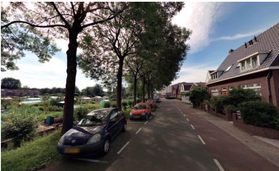
De teensloot heeft een houten beschoeiing, en vormt de scheiding tussen de volkstuinen en de dijk. In het steile binnentalud staat een rij essen. Op de kruin van de dijk liggen aan de binnenzijde de langsparkeerplaatsen, aan de buitenzijde een fietssuggestiestrook. De huizen en voor/zijtuinen staan op de bovenkant van het talud. Door de aaneenschakeling van woningen zijn er geen doorzichten naar de Gaasp.
