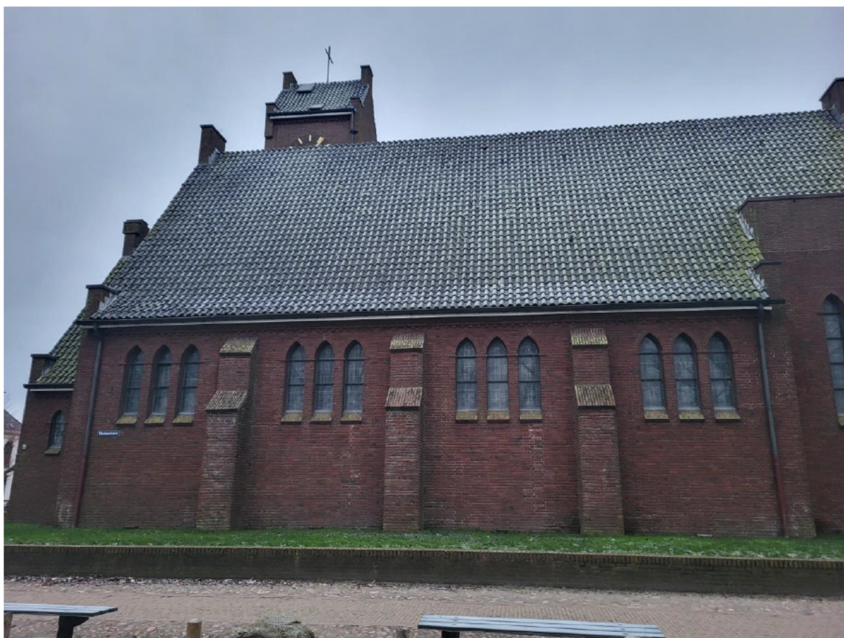
(0.4 Rechterzijde planobject met zicht op het dak en de glas in lood ramen.)
