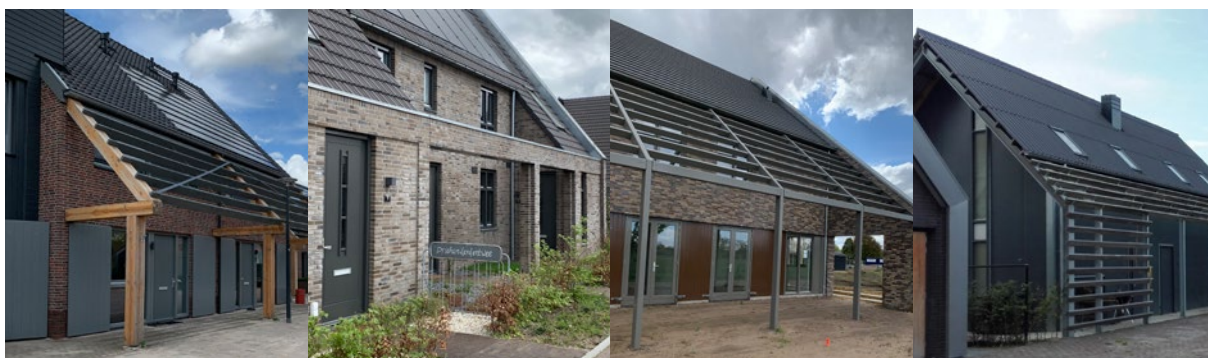
Afbeelding 312. Bouwkundige oplossingen om een lage goot te bereiken.
