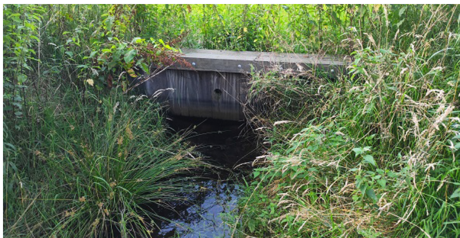
Afbeelding 24: Houten dam dienend als overstortconstructie naar waterschapssloot
