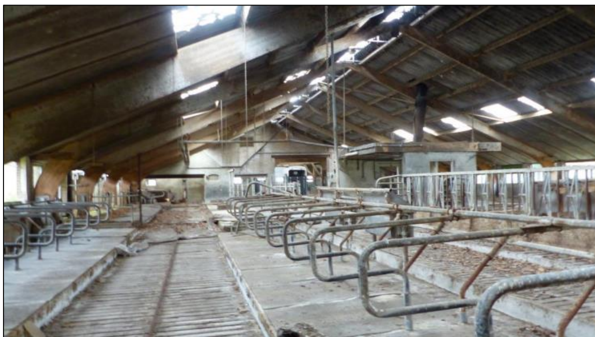
Figuur 2: binnenkant te slopen melkrundveestal (bron: Activiteitenplan)
