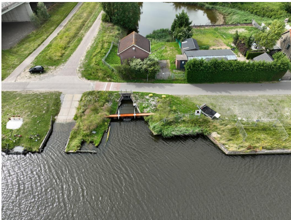
Afbeelding 2: bovenaanzicht huidige gemaal vanaf de boezem
