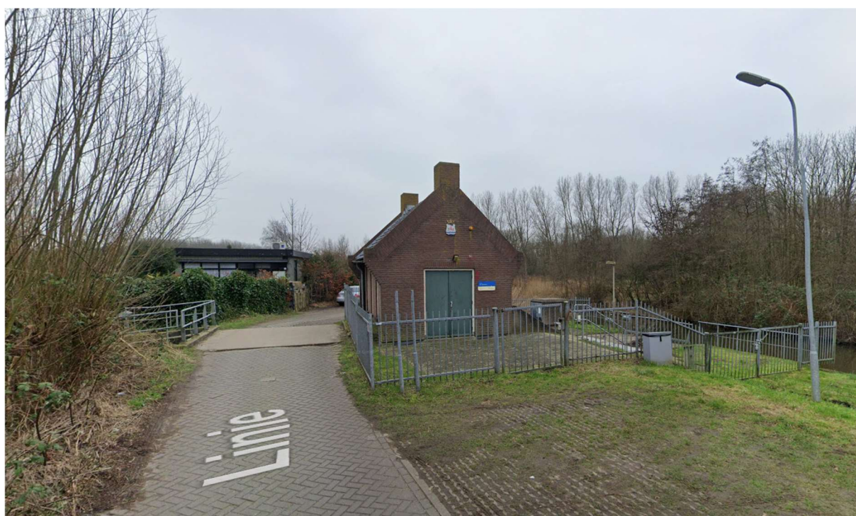
Figuur 2 – Poldergemaal De Dammers
