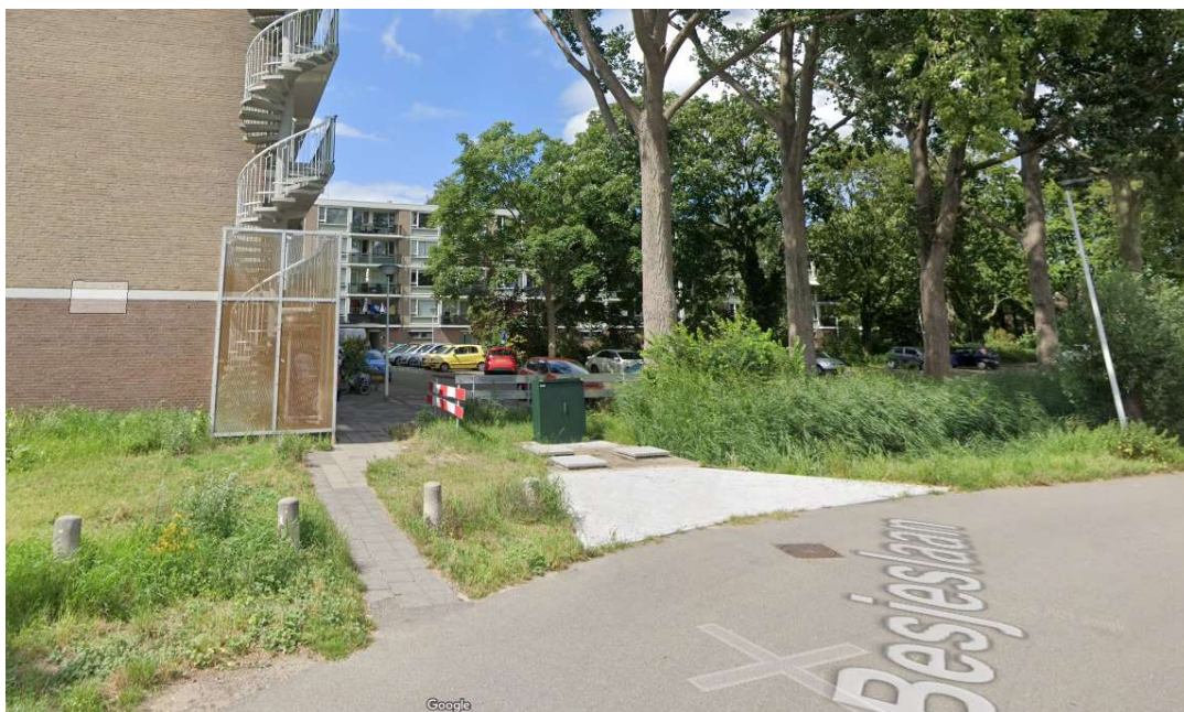
Foto 2. Huidige gemaal II
