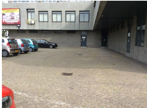
Fotonummer 14: Gericht noord ter plaatse van deellocatie 2.
