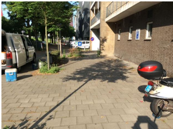
Fotonummer 1: Ter plaatse van de hbo-tank deellocatie 1.
