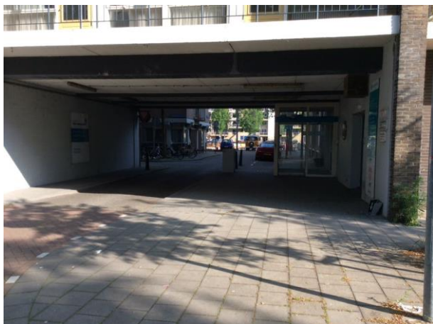
Fotonummer 3: Gericht noord ter plaatse van deellocatie 1.
