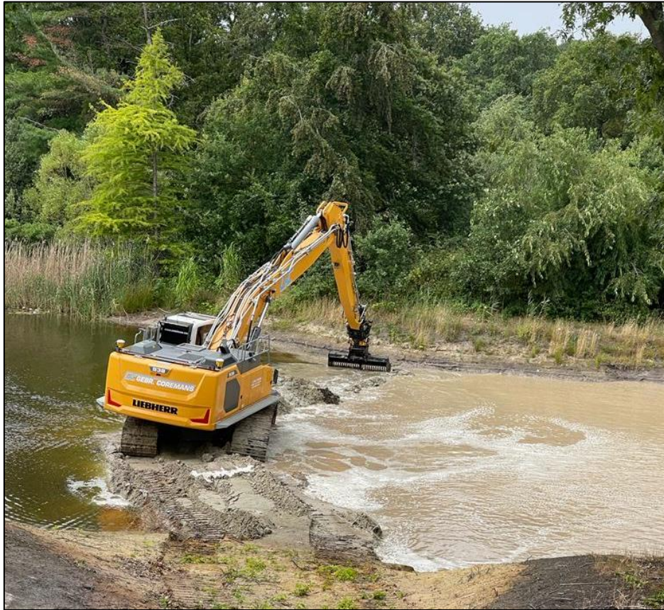
Verwijderen dammetje tussen bestaande water en nieuwe ontgraving (fase 1)
