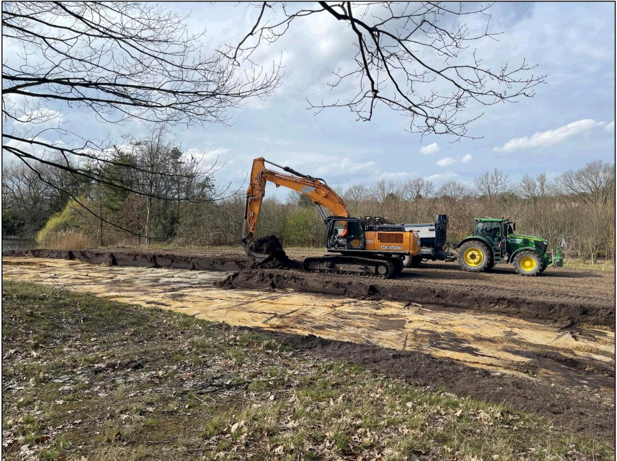
Verwijderen bouwvoor (fase 1 ontgroning)
