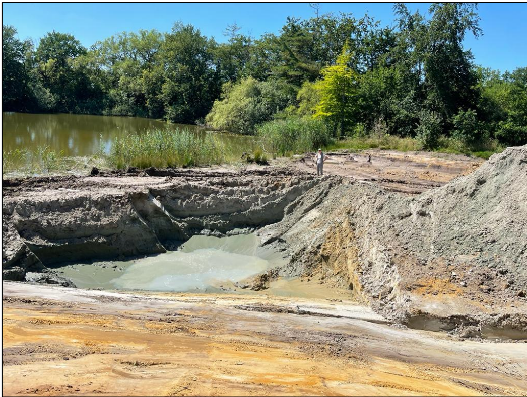
Laten staan van dammetje tussen bestaande plas en nieuwe ontgraving (fase 1)
