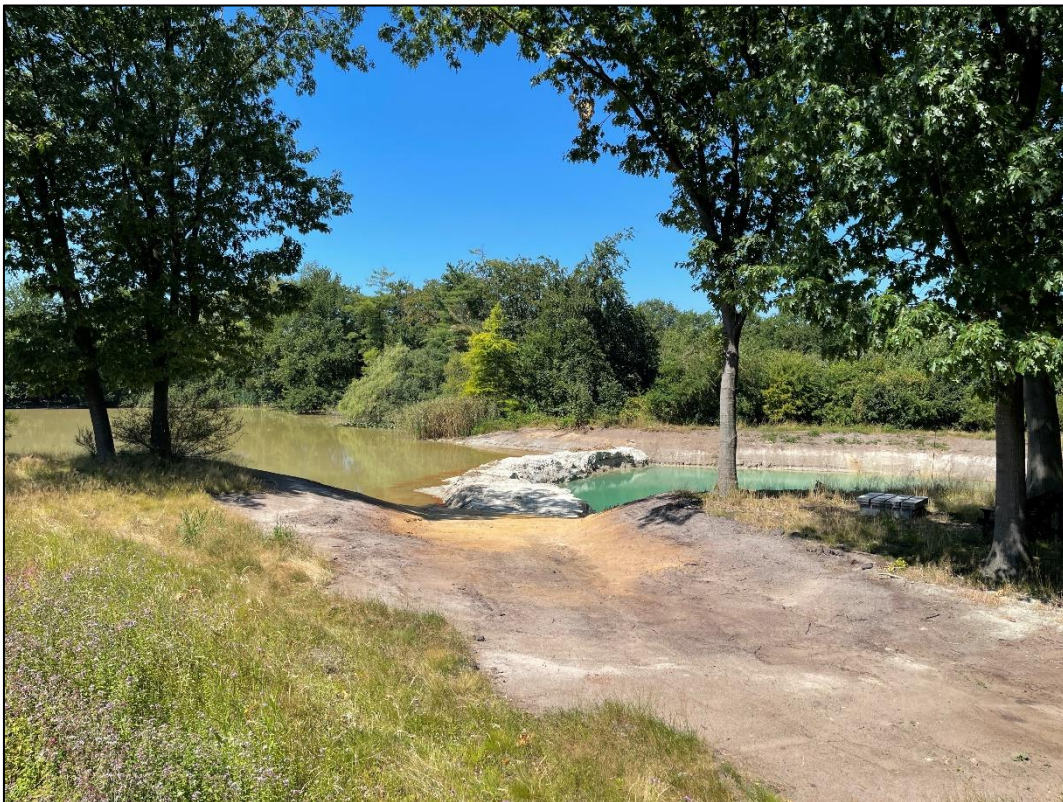
Laten staan van dammetje tussen bestaande plas en nieuwe ontgraving (fase 1)
