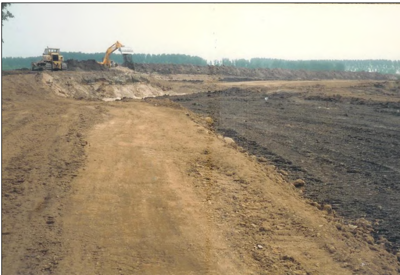
P02417_NOB_01: Naoorlogse kleiwinningsactiviteiten het plangebied. Te zien is dat met zwaar materieel de bovenste kleilaag tot op enkele meters diepte wordt afgegraven.
