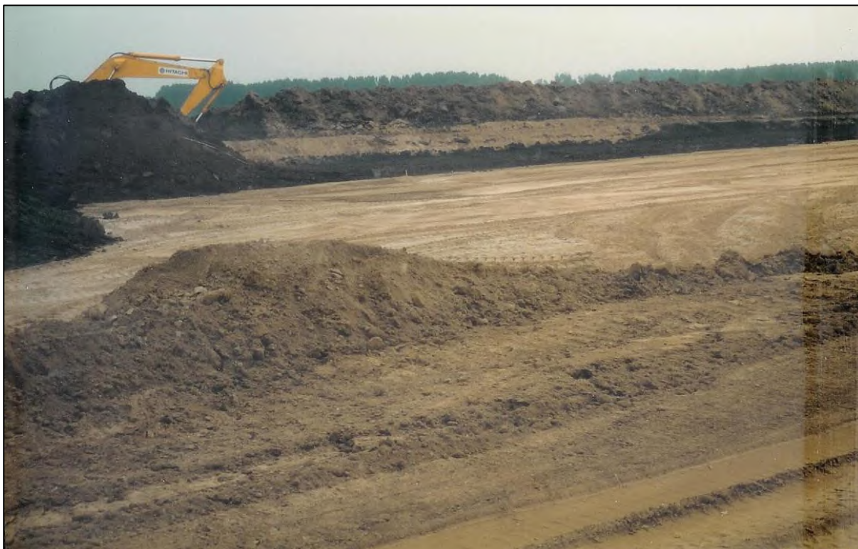
P02417_NOB_04: Naoorlogse kleiwinningsactiviteiten het plangebied. Op bovenstaand beeld is goed te zien dat er tot op de zandlaag klei wordt gewonnen.
