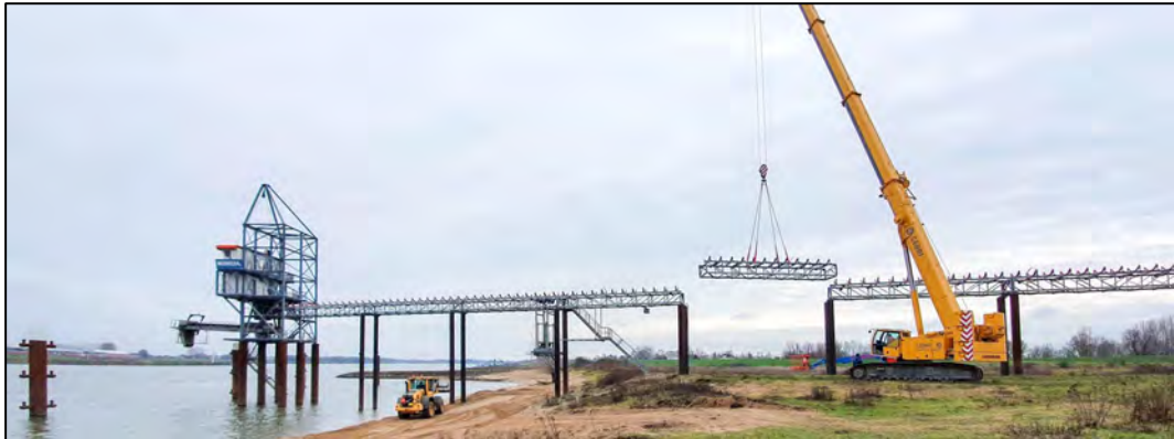
Figuur 2.10. Impressie van laadconstructie met transportband zoals deze ook voorzien is in de Waal en door het Natura 2000-gebied Rijntakken (Bron: K3delta).
