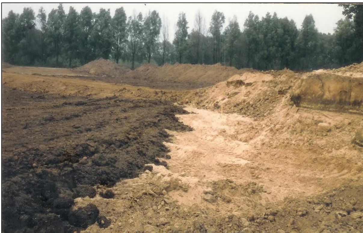
P02417_NOB_05: Naoorlogse kleiwinningsactiviteiten het plangebied waarbij de grond tot enkele meters diepte wordt ontgraven.
