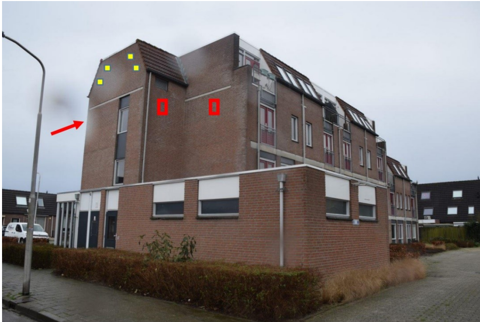
Figuur 5: Geplande locaties van de inbouwkasten (rood voor vleermuis, geel voor huismus) op verschillende zijden van het trappenhuis aan de noordzijde van het appartementencomplex aan de Heeskesacker.
