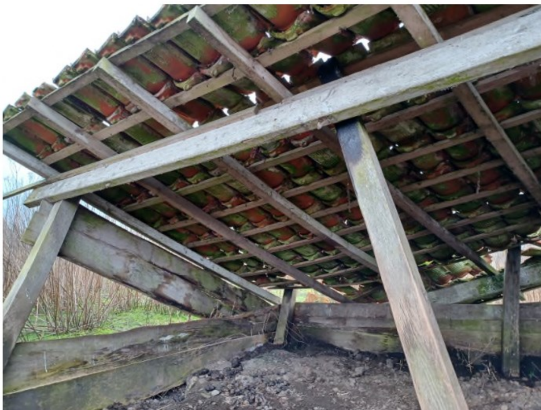
Figuur 5.1 Vervallen overkapping op eiland
