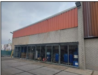
Figuur 3. Sfeerimpressie deellocatie 1, buitengevel zuidzijde.
