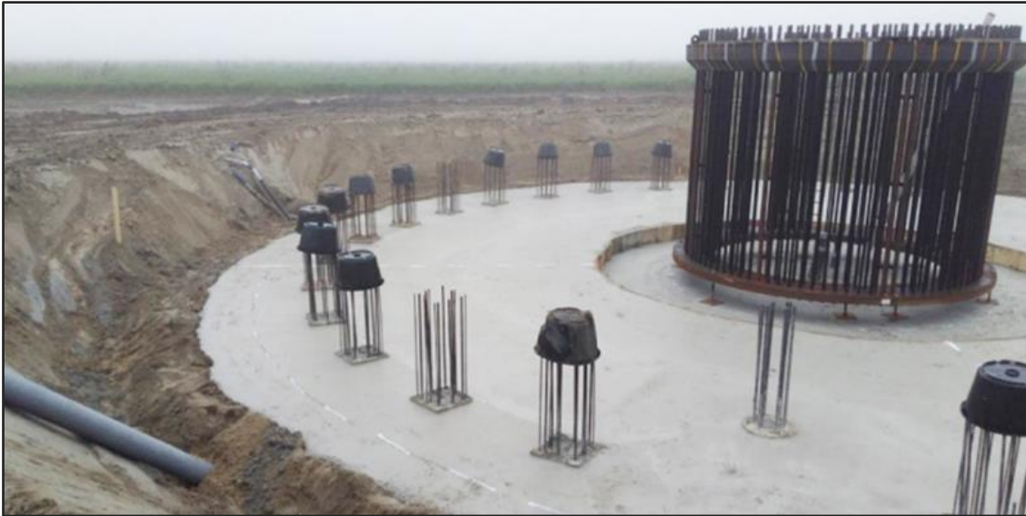
Figuur 3.3 Ankerkooi en wapeningsstaal heipalen (voorbeeld)
