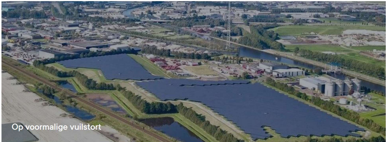
(voorbeeldfoto zonnepark op voormalige stortplaats Woldjerspoor, nabij voormalige Attero-vestiging in Groningen)
