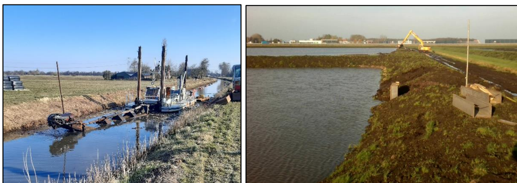
Figuur 1.3: Voorbeeldfoto's van baggerwerkzaamheden uitgevoerd met een snijkopzuiger (links), en een weilanddepot met kades waarin de baggerspecie wordt geloosd (rechts).
