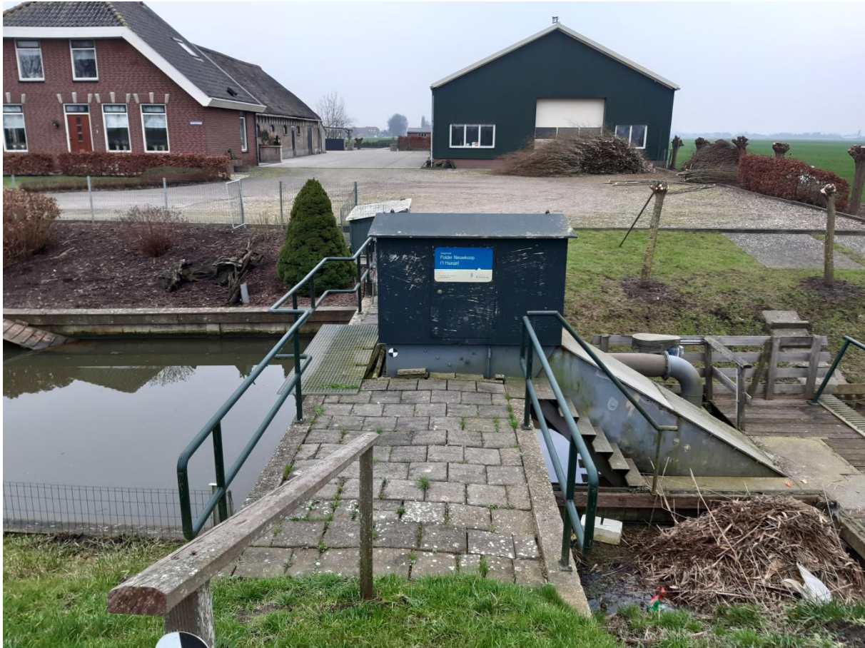
Afbeelding 5. Vakgemaal Nieuwkoop ('t Haasje) – huidige situatie
