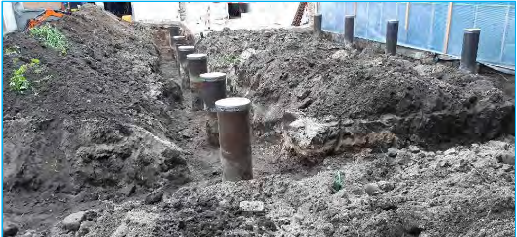
Foto 2: ontgraven funderingsleuf
