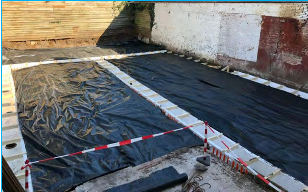
Foto 5: aangebrachte signaallaag
