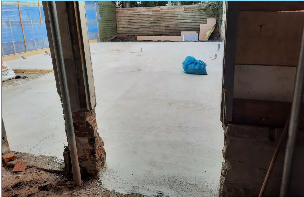
Foto 6: aangebrachte betonvloer
