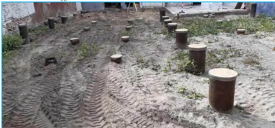
Foto 1: situatie voorafgaand aan de werkzaamheden
