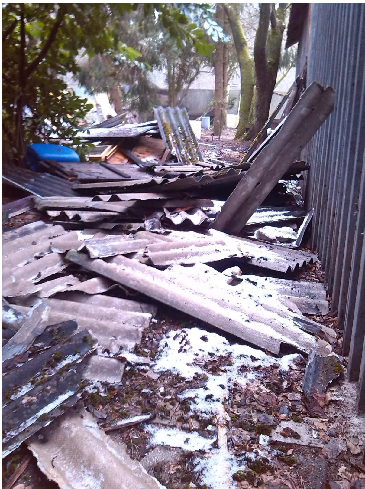
Foto 5: restanten asbestverdacht golfplaat bij werkplaats 3
