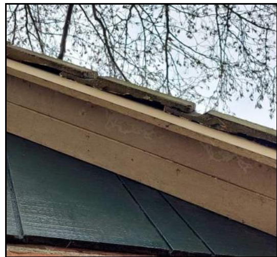
Afbeelding 4: Overhangend dakpannen met ruimtes
