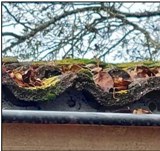
Afbeelding 3: Ruimte onder pannendak dichtgemaakt
