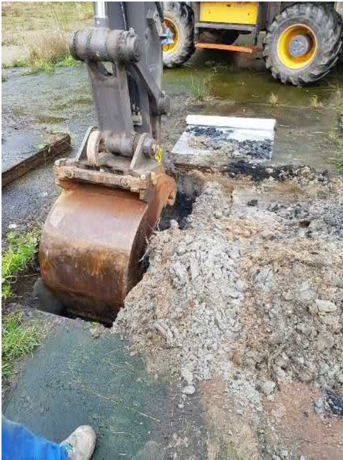
Afbeelding 4. Verwijderen van de stelconplaten met de onderliggende puinverharding. Foto Sweco 2020-01-07.
