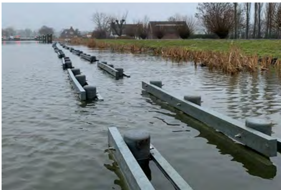
Figuur 27: Aangelegde golfbrekers bij dijverbetering Jaagpad
