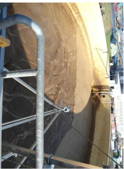
Beluchtingstank (Ø 10,5 m)
