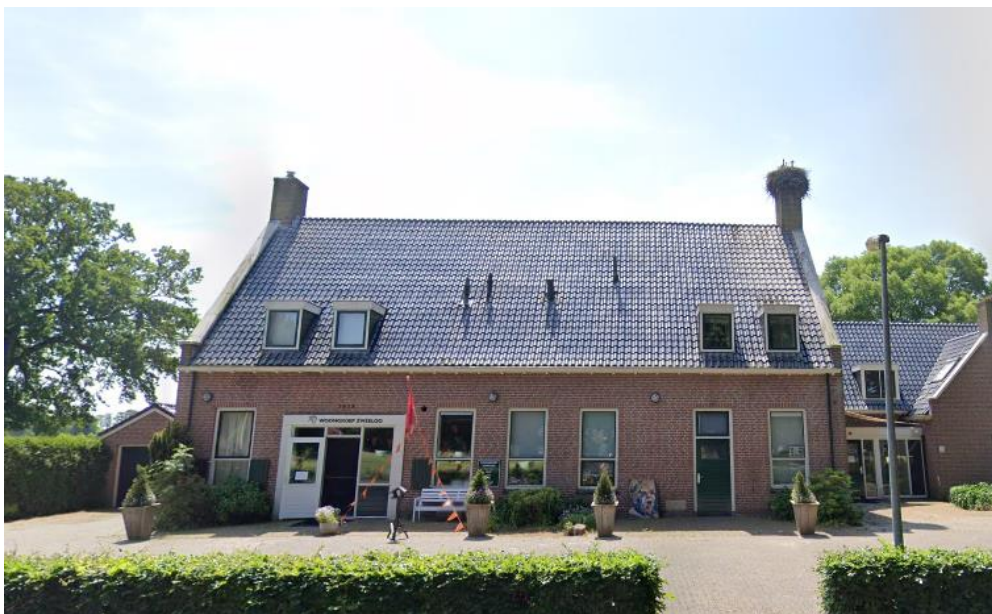
Figuur 2: bezet ooievaarsnest op een van de schoorstenen van woongroep Zweeloo (bron: Google Streetmaps)
